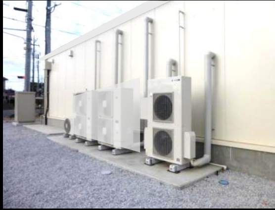
CO2 Cooling module 9kW
