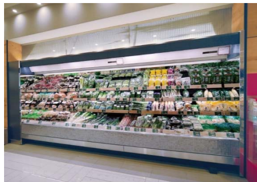
40台の冷凍・冷蔵ショーケースとプレハブ10室をノンフロン冷凍機で運転。
