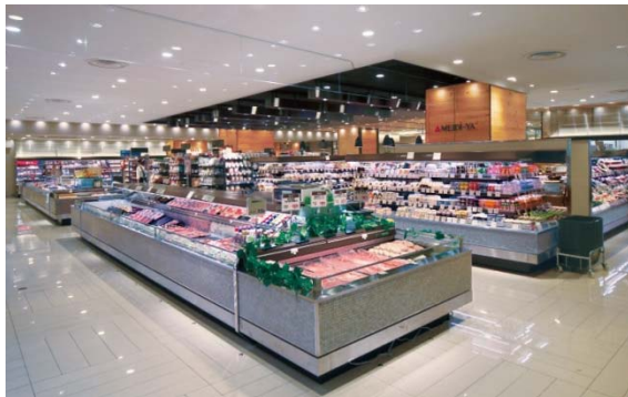
40台の冷凍・冷蔵ショーケースとプレハブ10室をノンフロン冷凍機で運転。
