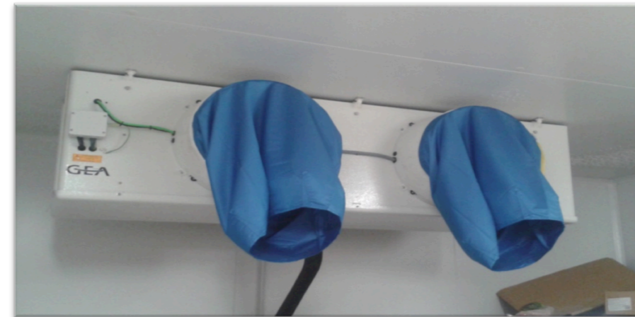
Evaporador en cámaras de congelado
