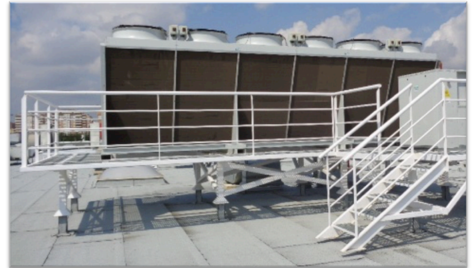
Gascooler y Subcooler
