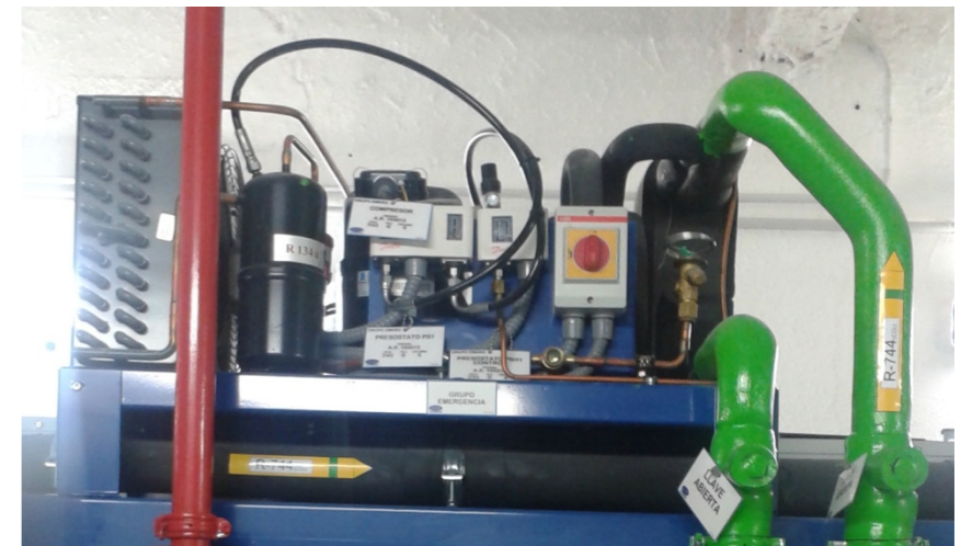
Unidad de emergencia
