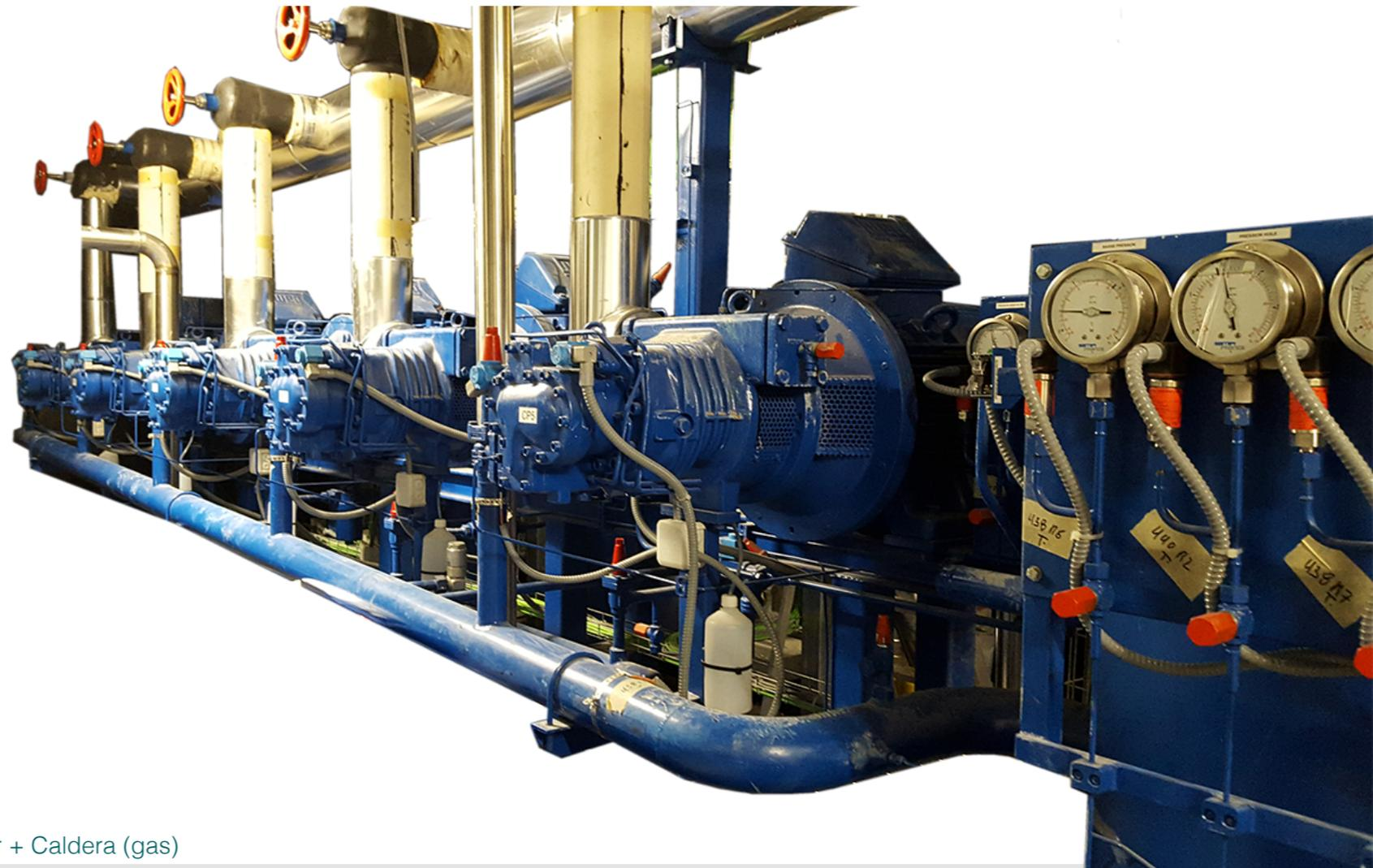
Frío MT – NH3/Glicol, inclui condensación del CO2 BT; HVAC – Chiller + Caldera (gas)
