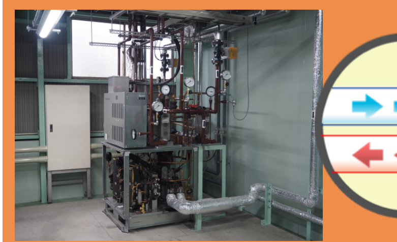
CO2 Refrigeration system CO 2 冷凍システム
