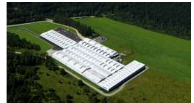
Usine de Kaplice (Rép. Tchèque) Meubles hauts, froids positif & négatif
