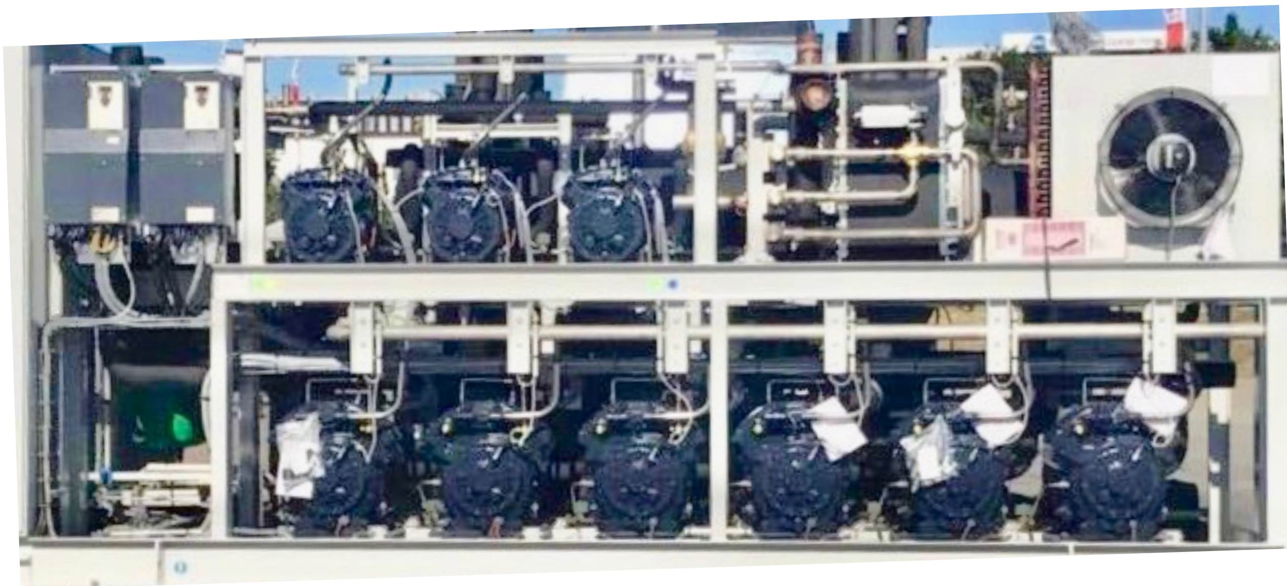
RACK AVEC COMPRESSEURS DORIN 6 CYL. TRANSCRITIQUE – 53 m 3 /h – 80 hp COURTESY: PROFROID – GREEN & COOL
