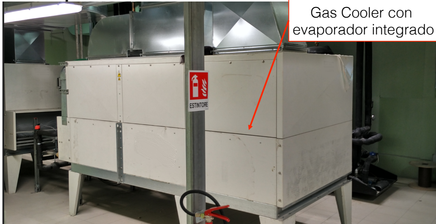
Vista del evaporador integrado
