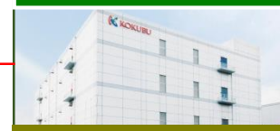
船橋流通センター
